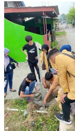
Gambar 7 Pemasangan Penanda Jalan
