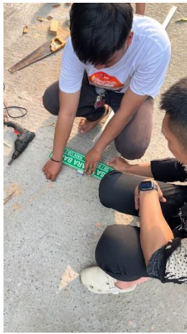
Gambar 6 Perakitan Penanda Jalan
