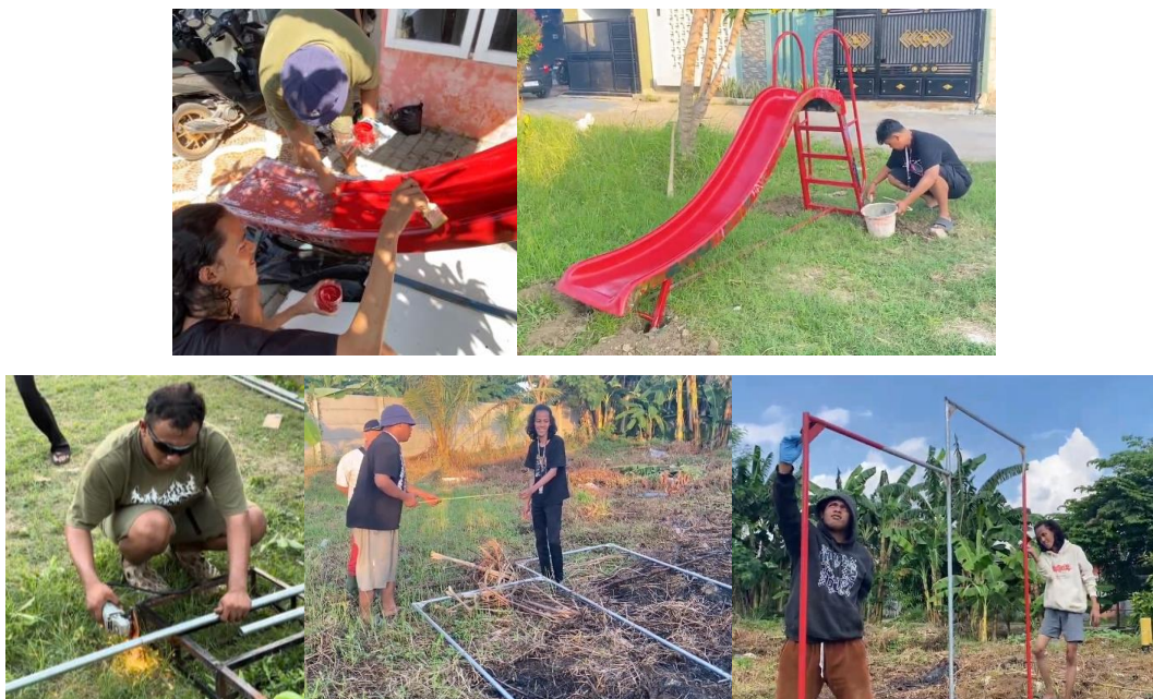
Gambar 3. Proses Perakitan, Pengecatan dan Penempatan Perosotan dan Tiang Pull-Up
