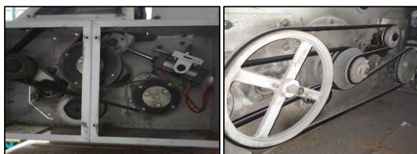
Gambar 2. Proses Pembersihan Pulley dan V-belt
